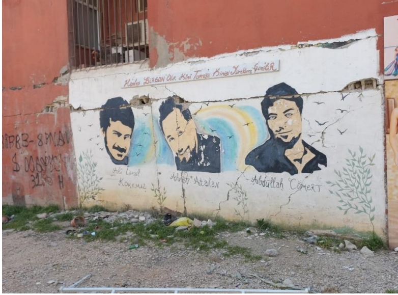
Ali İsmail Korkmaz, Ahmet Atakan, Abdullah Cömert. / Armutlu'da hasar görmüş bir bina.
